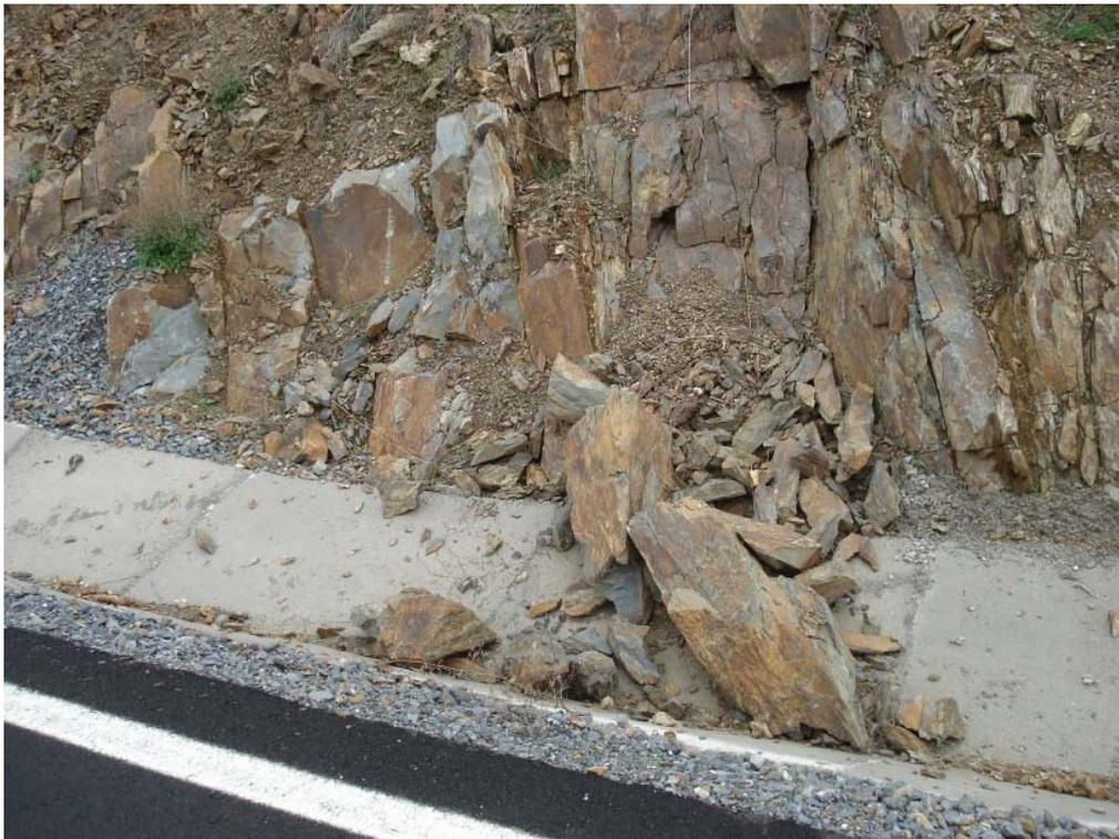
*Foto2. Detalle de talud rocoso con bloques que fallan y bloques caídos en la cuneta (Ciudad Real).*
